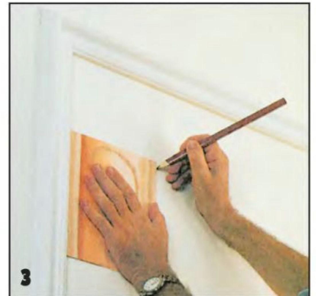
3 Прикладывая изнутри к профилям кусок бордюра в качестве шаблона, помечают положение внутренней рамки.
