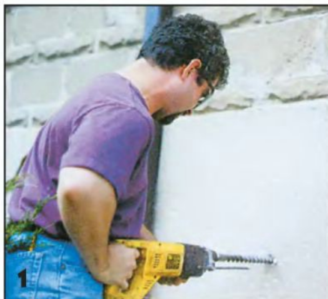
1 Выбрав место, перфоратором с буром сверлят в фундаменте отверстие необходимого диаметра. Чтобы вода не проникла в фундамент, отверстие должно идти немного вверх.
