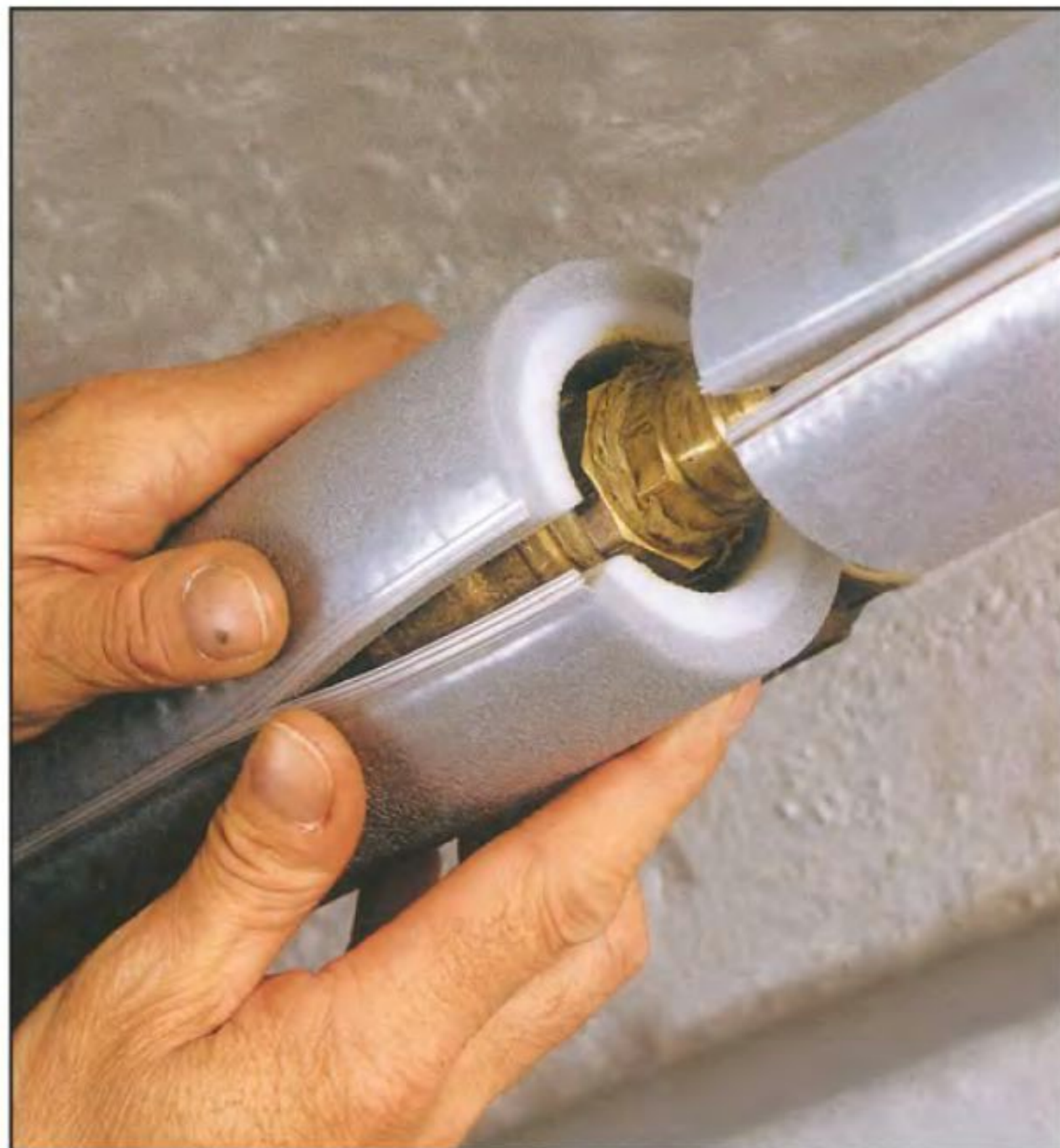
В этом месте стыкуются одна с другой две трубы различного диаметра. Надеваемые на трубы теплоизоляционные оболочки вплотную прижимают друг к другу и закрепляют самоклеящейся лентой, располагаемой по шву между краями замкнутых в кольцо оболочек.
