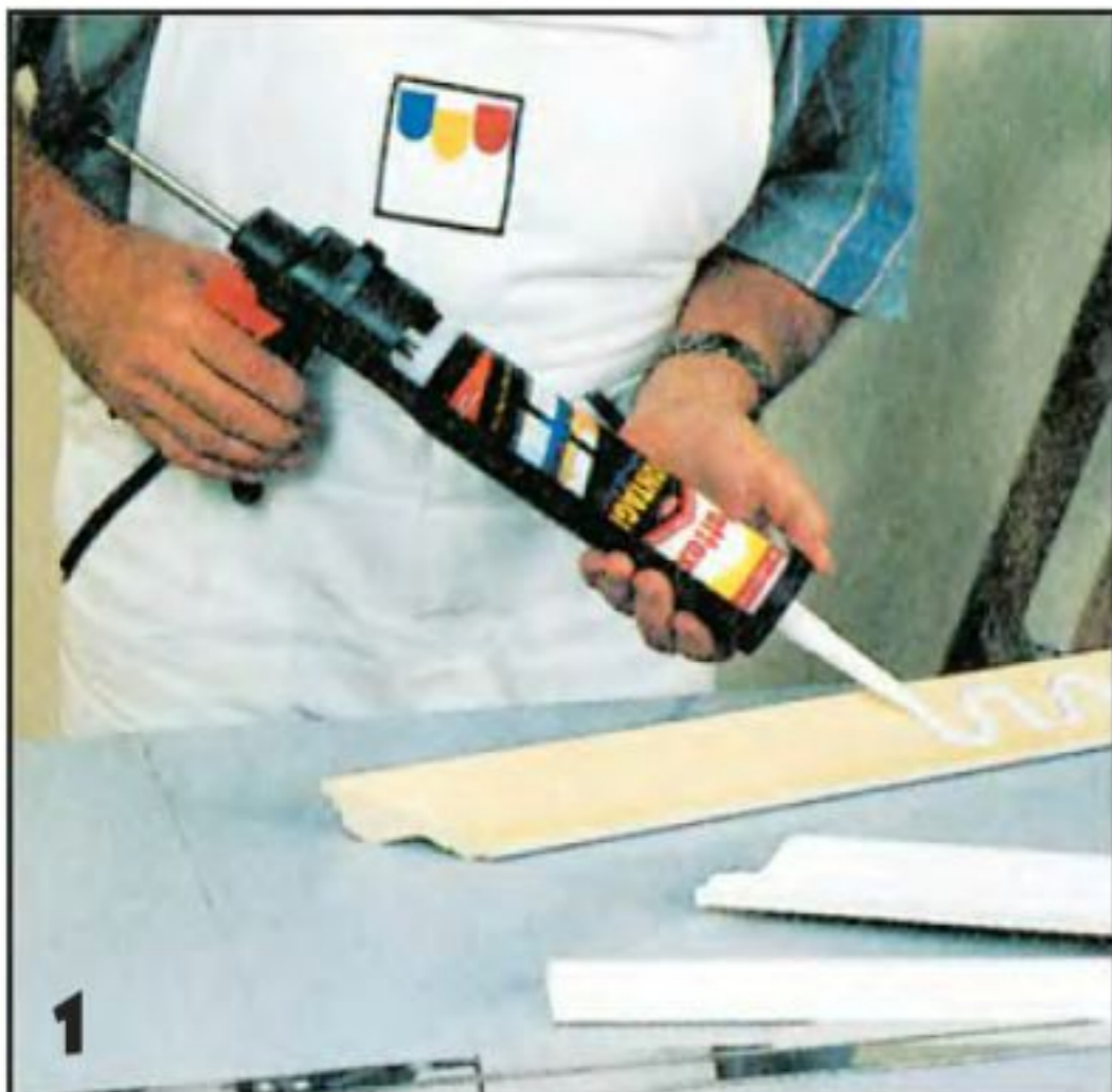
1 На профили, заранее раскроенные по длине и запиленные «на ус» мелкозубой пилой, наносят монтажный клей.
