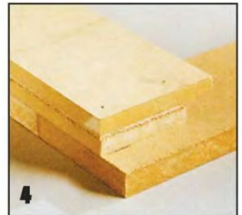
Верхний направляющий профиль, прикрепляемый к торцевой кромке, образует вместе с рамой фальц, служащий опорой для подоконника.
