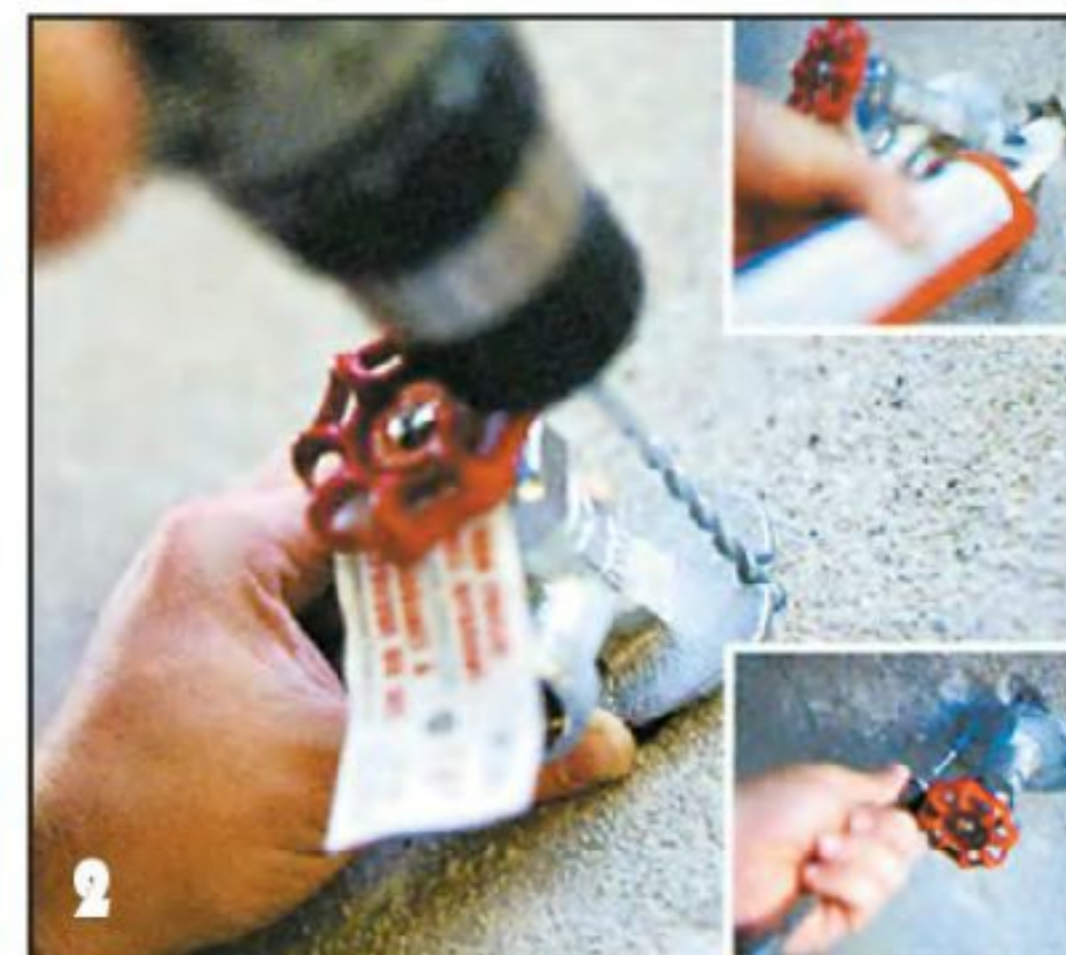
2 Пропускают шток сквозь стену и для винтов крепления крана сверлят отверстия. Вверху: опору крана ставят на герметик. Внизу: крепление крана.
