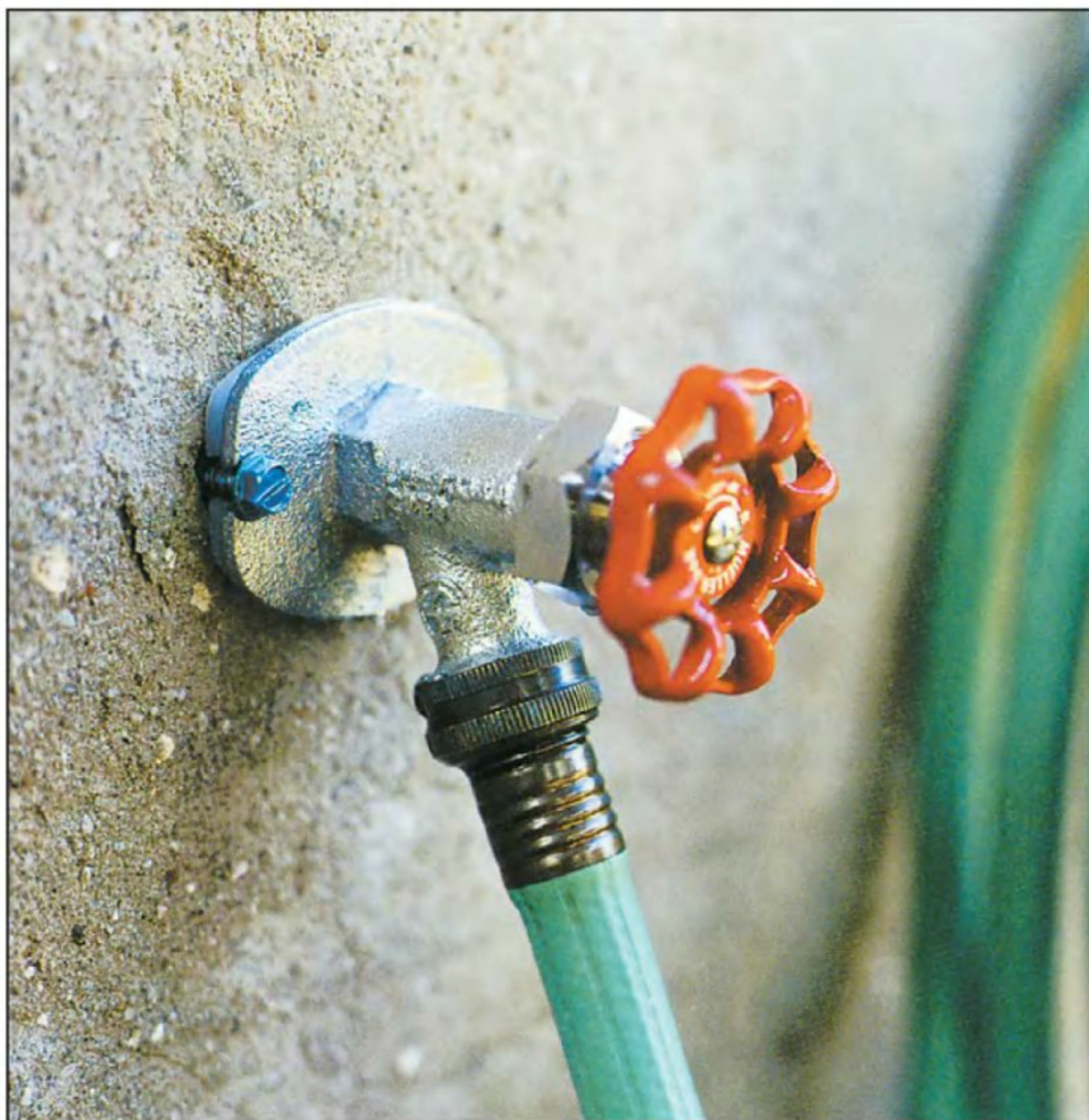
Прекрасная ручка. Клапан этого крана для шланга находится за стеной фундамента далеко от управляющего им маховичка, поэтому он не замерзает весь год.
