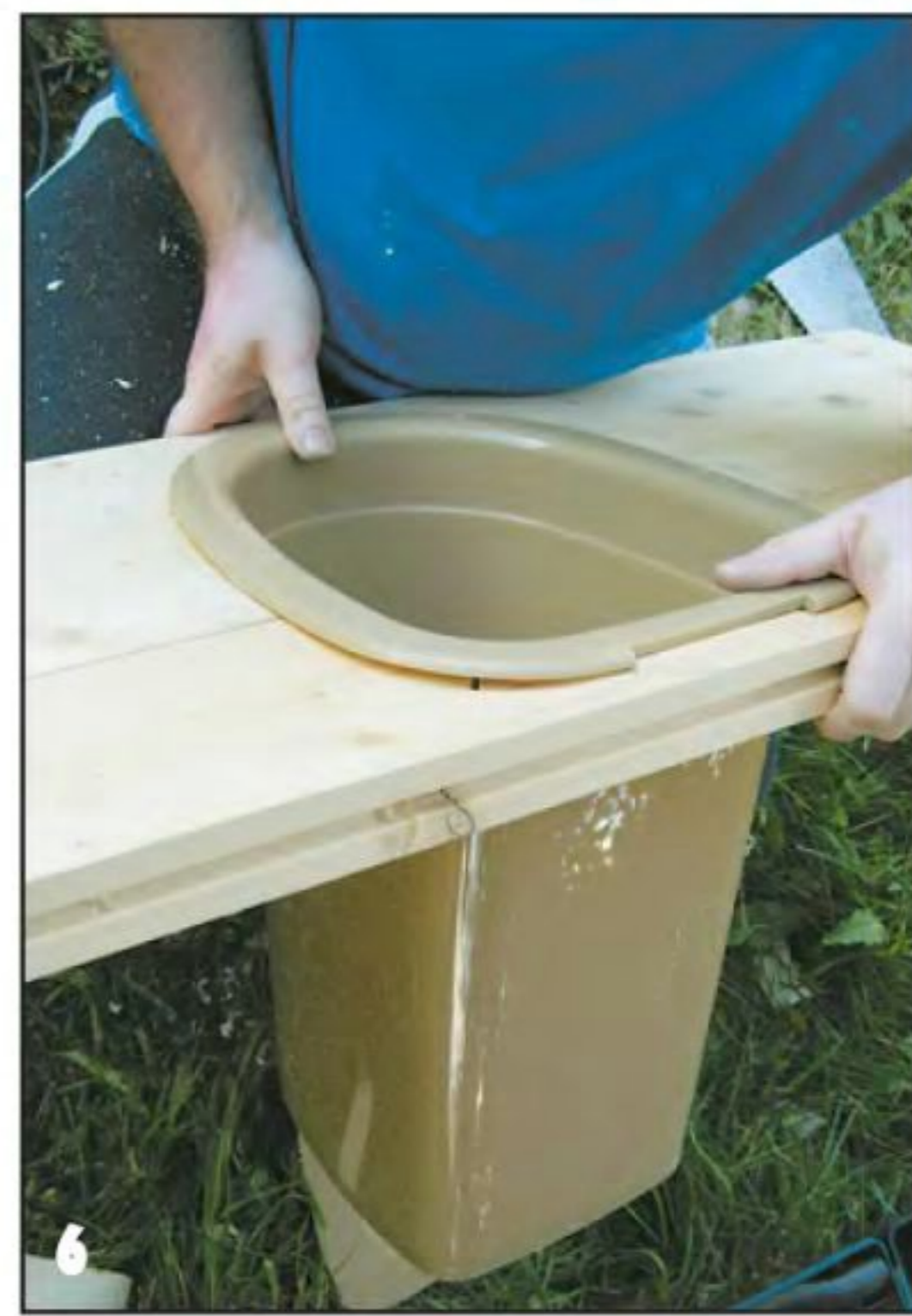
Выполнив все пропилы, убедились, что ведро хорошо подогнано, плотно входит в проём и бортик его при этом ложится на деревянное сиденье унитаза.
