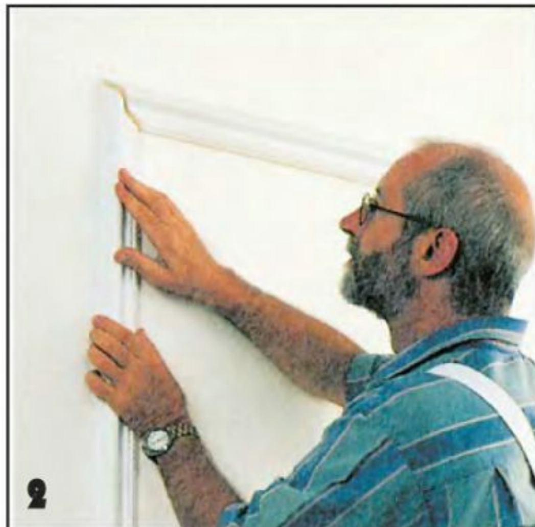
2 Профиль приклеивают к стене по намеченным карандашом линиям. Сначала крепят профили наружной рамки.
