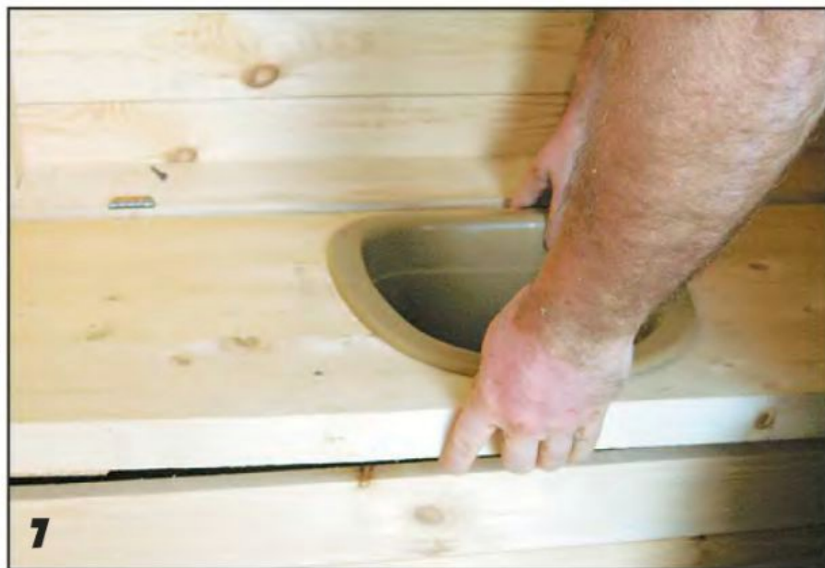
Деревянное сиденье с пластиковым ведром-вставкой вернули на своё место, закрепив саморезами на картонных петлях.
