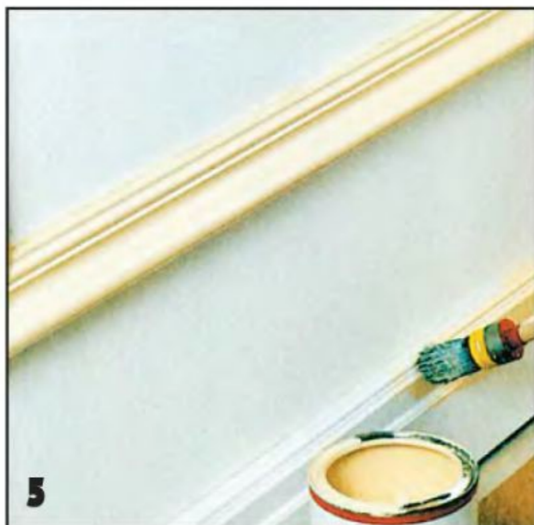
Прежде чем оклеивать стену обоями, профили покрывают лаком в тон потолочным карнизам.
